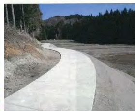
開水路（蓋掛け後）
