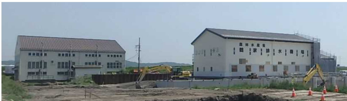
左：旧排水機場 右：建築中の新排水機場
