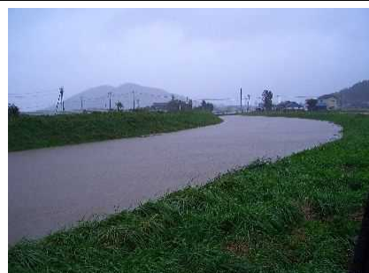
旧古川排水路(旧後谷地排水機場付近)
