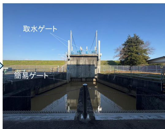
工事後 (取水ゲート)
