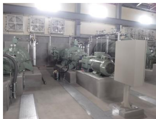
工事後 (ポンプ)
