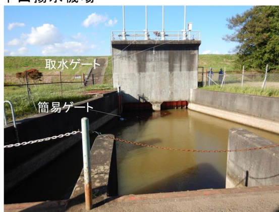
工事前 (取水ゲート)
