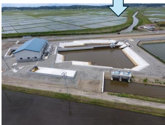
工事後 (遊水池)
