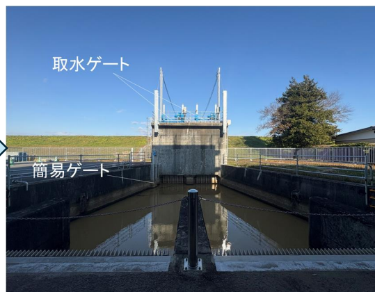
工事後 (取水ゲート)
