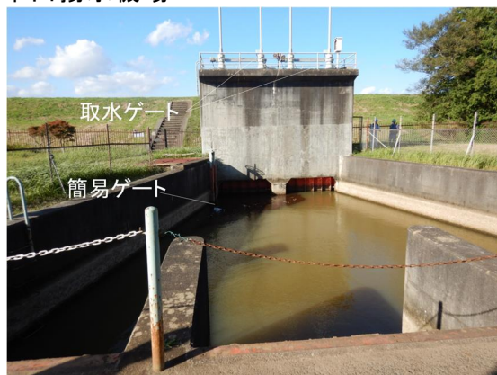
工事前 (取水ゲート)
