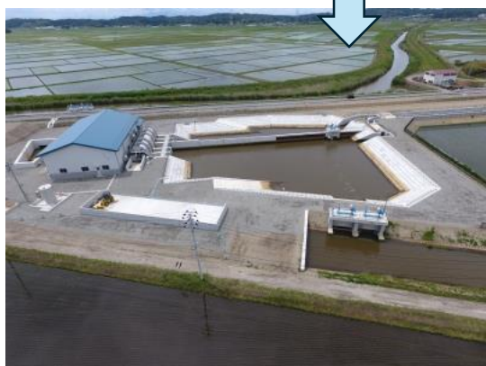
工事後 (遊水池)
