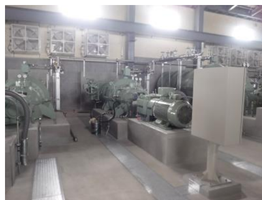
工事後 (ポンプ)
