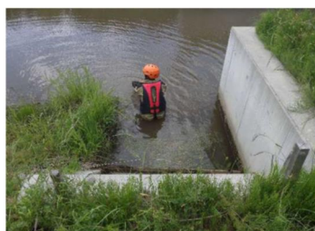
調査状況（排水路）
