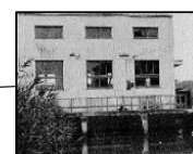
大曲排水機場
