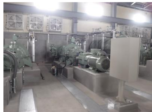
工事後 (ポンプ)
