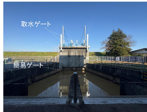
工事後(取水ゲート)
