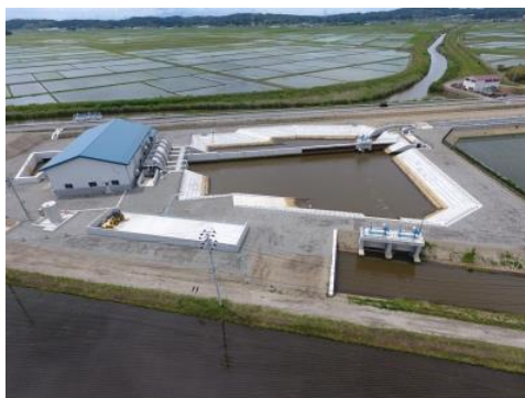
工事後 (遊水池)
