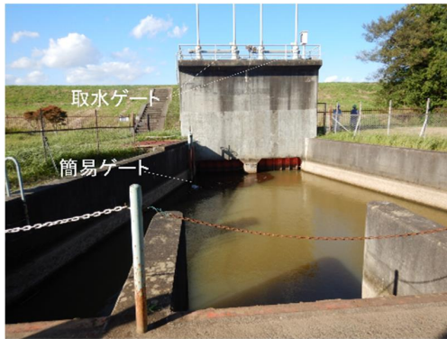
工事前(取水ゲート)
