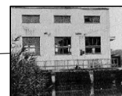
大曲排水機場
