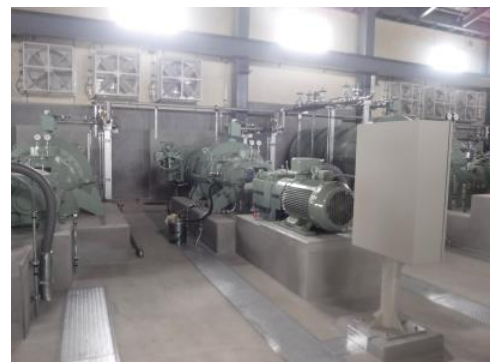
工事後 (ポンプ)
