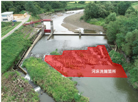
新上堰頭首工（改修前）
