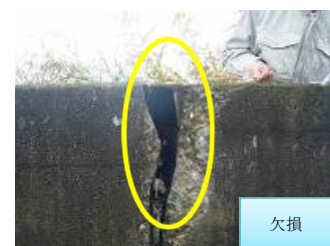
旭川左岸幹線用水路 現場打水路
