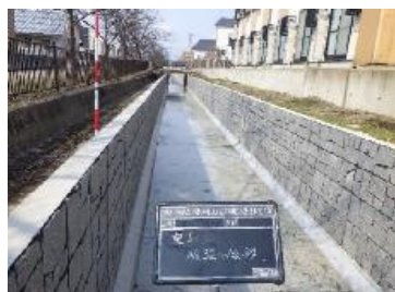
修景パネルが貼付された水路壁
