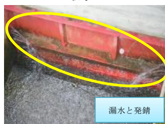
新上堰頭首工 取水口
