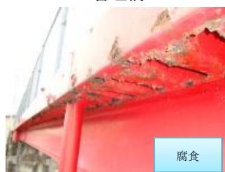
大戸川頭首工 管理橋
