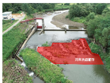
新上堰頭首工(改修前)
