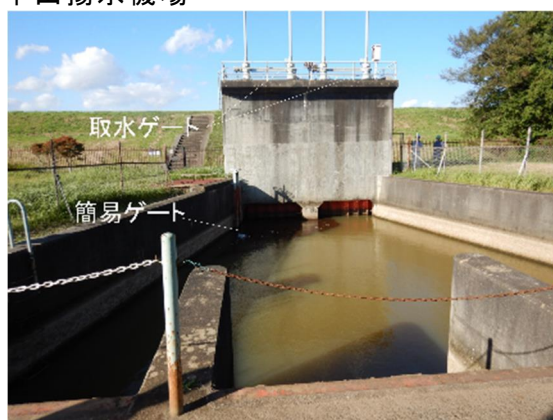
工事前（取水ゲート）
