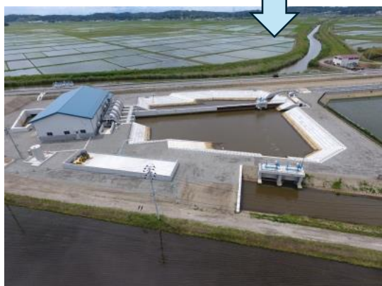
工事後（遊水池）
