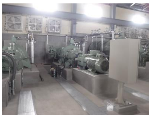
工事後（ポンプ）
