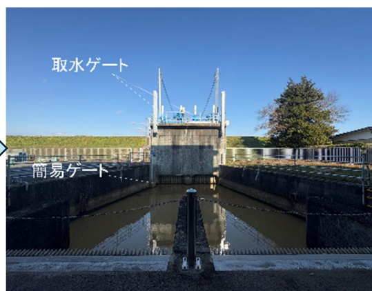
工事後（取水ゲート）
