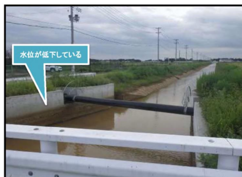
整備後の様子（非かんがい期）
