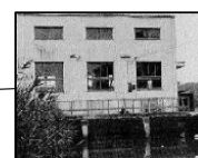
大曲排水機場
