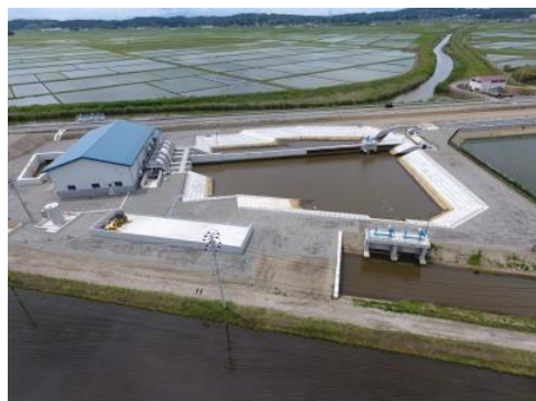
工事後(遊水池)
