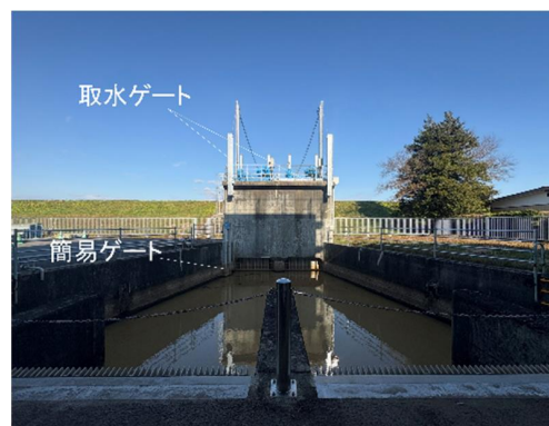
工事後(取水ゲート)
