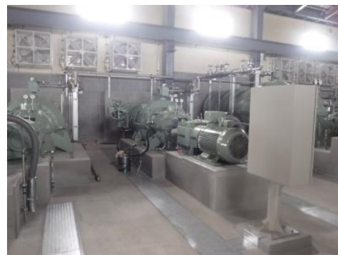
工事後(ポンプ)
