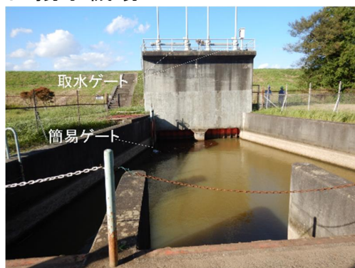
工事前(取水ゲート)
