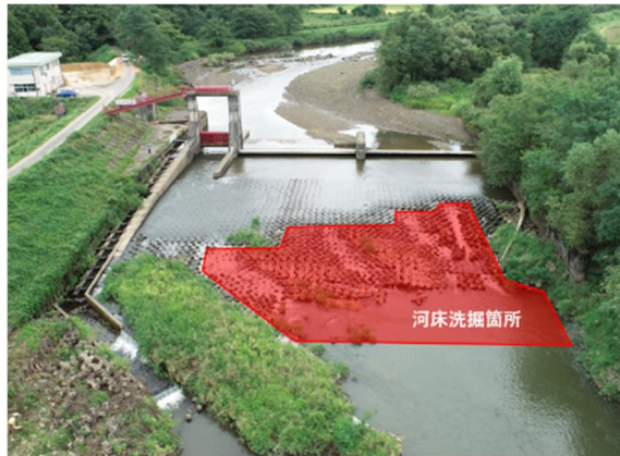
新上堰頭首工（改修前）
