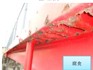
大戸川頭首工 管理橋
