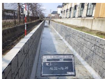
修景パネルが貼付された水路壁
