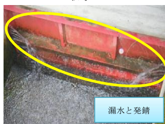
新上堰頭首工 取水口
