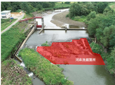
新上堰頭首工(改修前)
