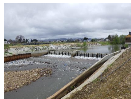
大戸川頭首工
