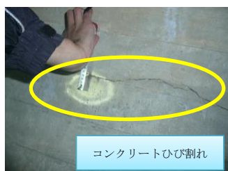
あいののダム 取水隧道(隧道部)
