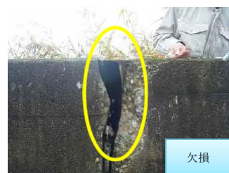
旭川左岸幹線用水路 現場打水路
