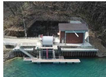
改修後 (除塵機改修、船舶格納庫建築、浮棧橋設置)
