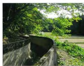
開水路（蓋掛け前）
