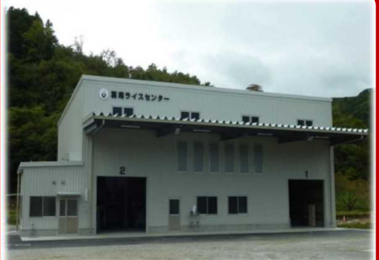
葛尾ライスセンター (令和3年度稼働)
