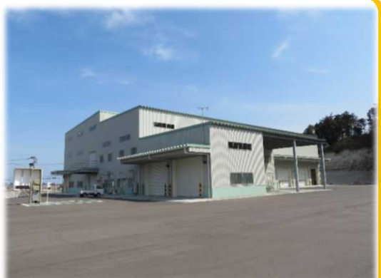
小高カントリーエレベーター (令和3年度稼働)
