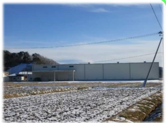
川内村米備蓄倉庫 (平成29年度稼働)
