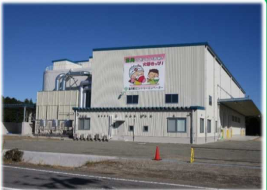
富岡町ントリーエレベーター (令和4年度稼働予定)
