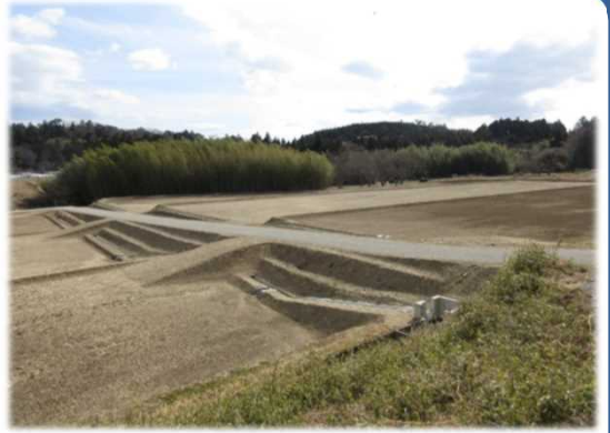
ほ場整備完了予定 (広野町上北迫地内)
