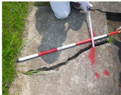
連節ブロック天端コンクリート ひび割れ状況
