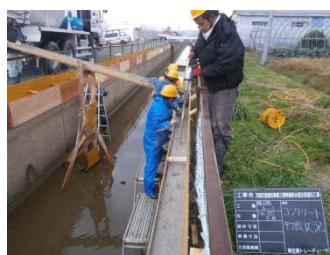
型枠・打設状況
