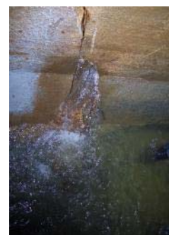
樋管内部漏水状況
