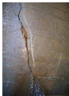
樋管内部漏水状況
