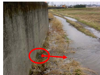
・亀裂・漏水
