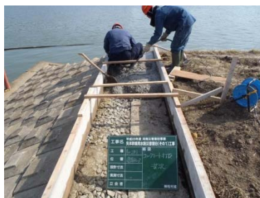
天端コンクリート打設 状況
