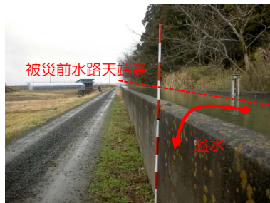
・水路沈下(通水阻害)
