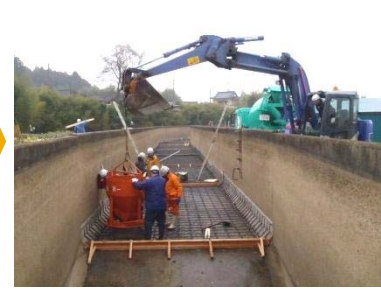
・コンクリート打設
