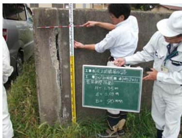
・継目破損
