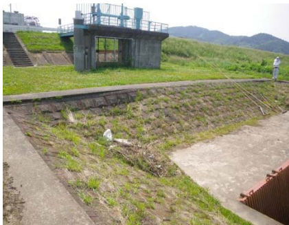
取水口連節ブロック沈下状況
