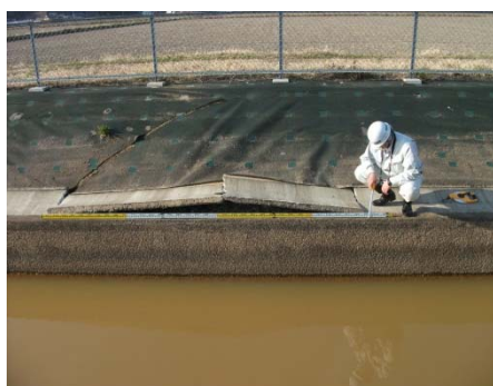
法張りコンクリート破損
