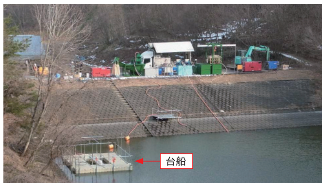
浚渫除去（剥離洗浄工法）の実施状況
