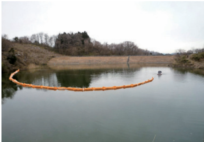
汚濁防止フェンス設置状況
