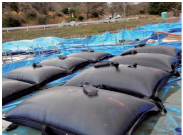
袋詰脱水：脱水養生中の状況
