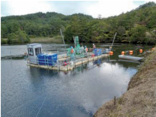
ポンプ浚渫の状況
