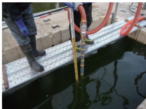
ポンプ吸引状況
