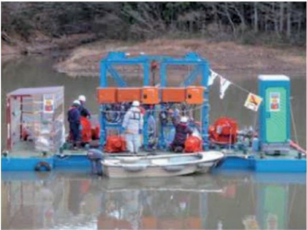
ポンプ浚渫の状況
