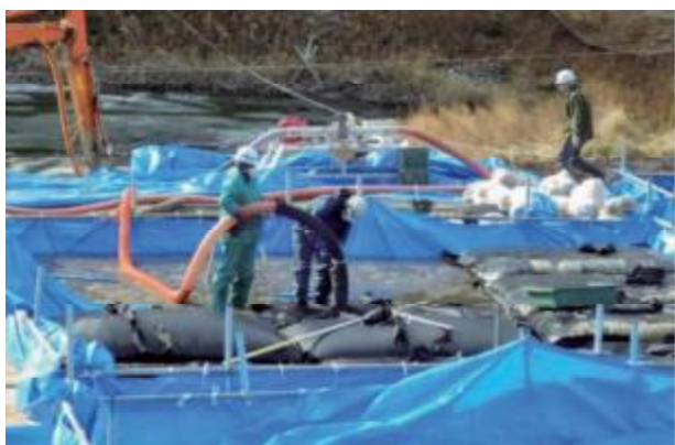
袋詰脱水：脱水袋への底質の充填作業
