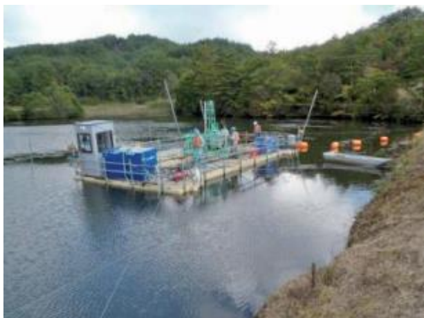
ポンプ浚渫の状況
