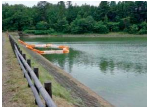
フェンス設置後の状況
