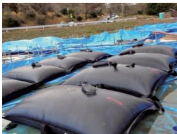
袋詰脱水：脱水養生中の状況
