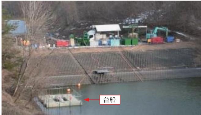
浚渫除去（剥離洗浄工法）の実施状況
