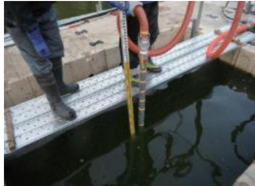
ポンプ吸引状況
