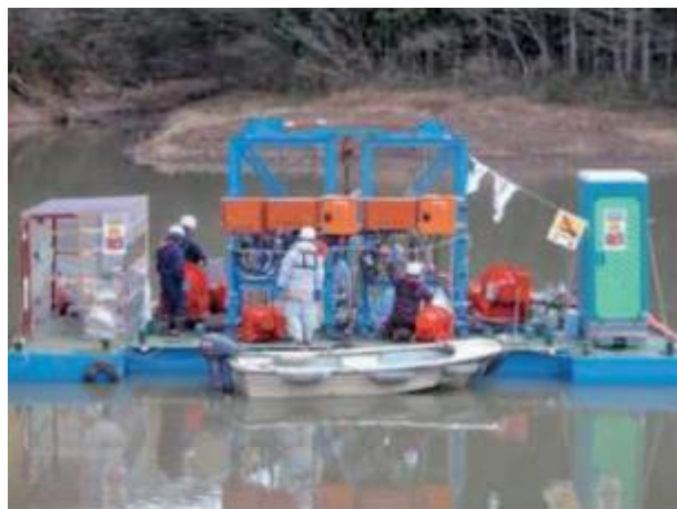
ポンプ浚渫の状況
