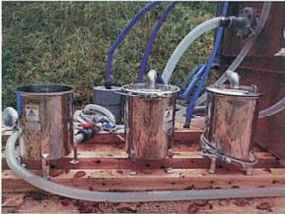
吸着除去設備（処理タンク）設置状況
