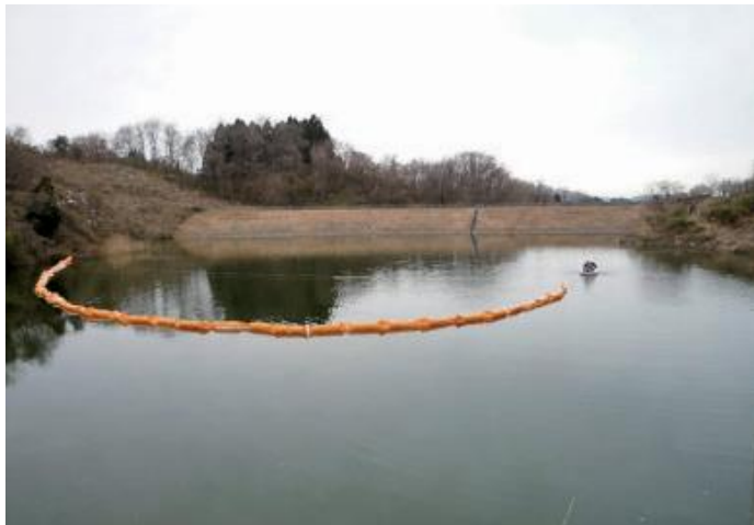
汚濁防止フェンス設置状況
