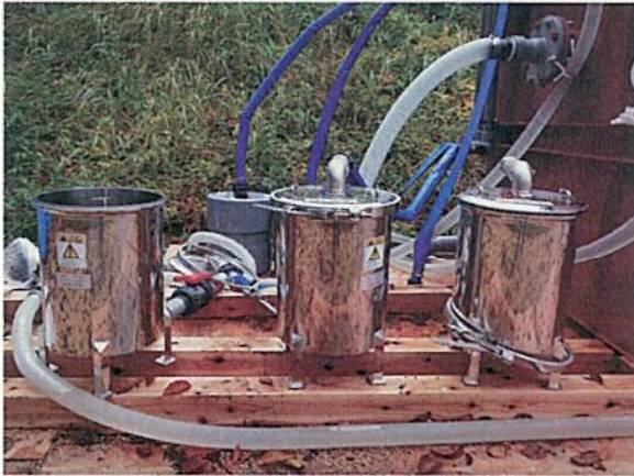
吸着除去設備（処理タンク）設置状況
