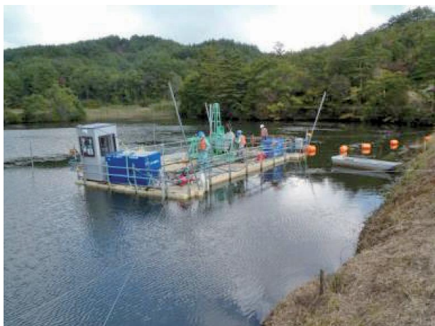
ポンプ浚渫の状況
