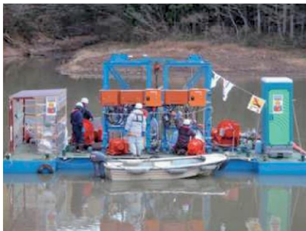
ポンプ浚渫の状況
