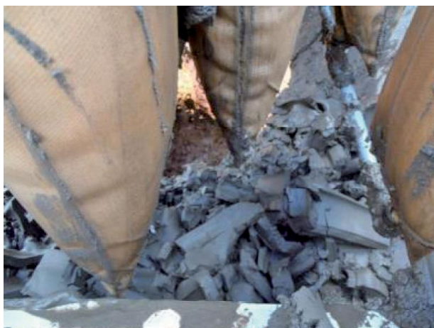
マルチドレーン真空脱水：剥離直後の脱水ケーキ
