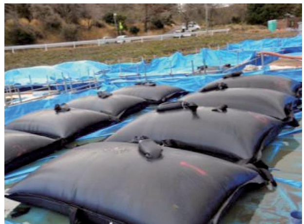
袋詰脱水：脱水養生中の状況
