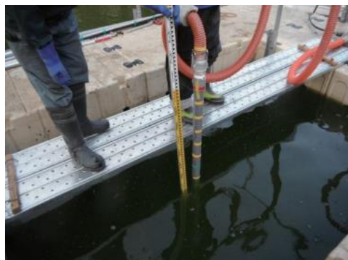
ポンプ吸引状況
