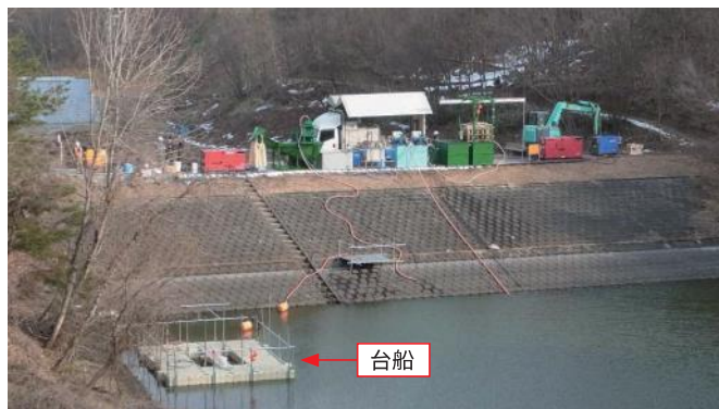
浚渫除去（剥離洗浄工法）の実施状況
