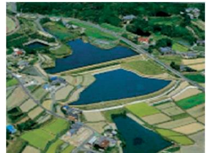
棚状に複数のため池が連なっているため池
