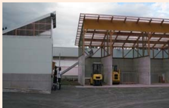
堆肥舎(事業対象施設)
