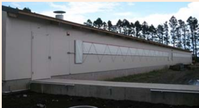
開閉可能式の肥育舎(事業対象施設)
