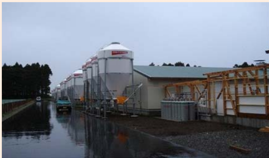
移転建設した養豚施設(事業対象施設)
