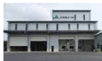
新設したカントリーエレベーター
