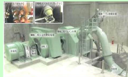
(右) 横軸単輪二射ペルトン水車 (左) 横軸三相交流同期発電機 (2階)
