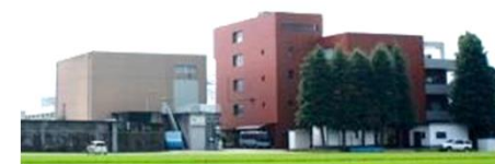
施設全景 （左）発電所 （右）土地改良区
