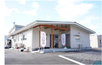
<処理施設の外観>
