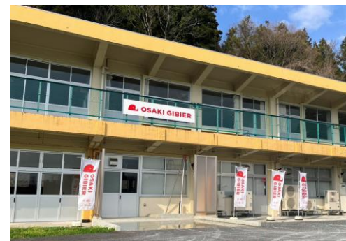
＜処理施設の外観＞
