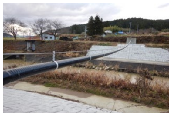
接続管新設（河川横断部）
