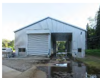
養豚施設に入る車を洗浄する施設
