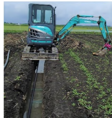
暗渠の点検のためにほ場を掘り起こした様子
