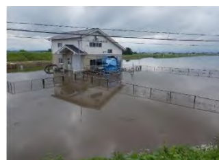
矢ノ目排水機場の冠水 （宮城県大崎市 おおさきし ）
