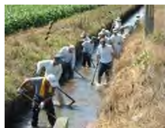
水路の泥上げ
