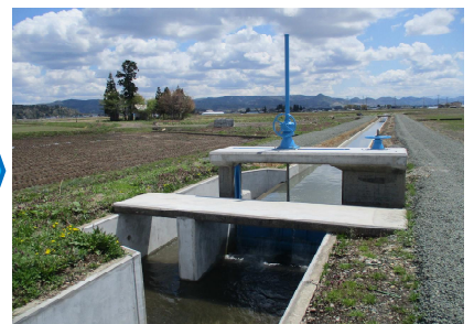
老朽化した水路及び分水ゲートを更新
