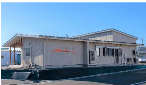
新設した大槌町ジビエ処理加工施設 (令和5(2023)年3月完成)
