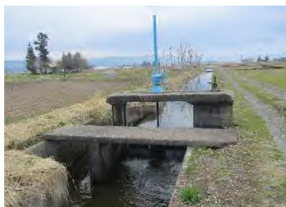
老朽化した水路及び分水ゲートを更新
