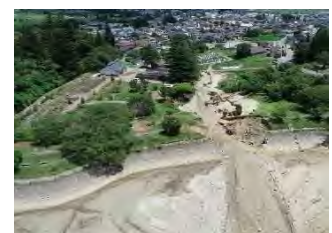
大光堤1号ため池の決壊 （山形県川西町 かわにしまち ）
