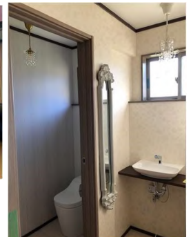
改修した女性用トイレ
