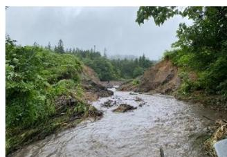
堤体の部分的な崩壊によるため池の被災状況
