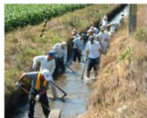
水路の泥上げ
