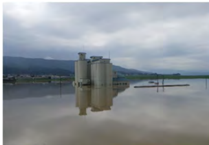
カントリーエレベーターの浸水(山形県酒田市)
