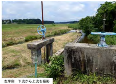
左岸側 下流から上流を撮影
