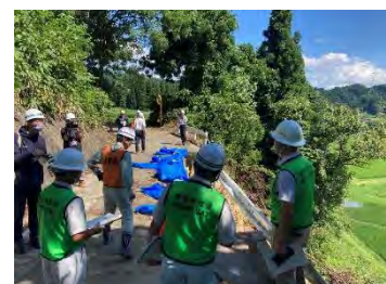
被災現場での復旧技術支援(山形県舟形町)
