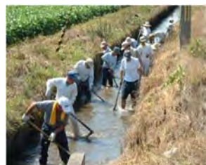
水路の泥上げ
