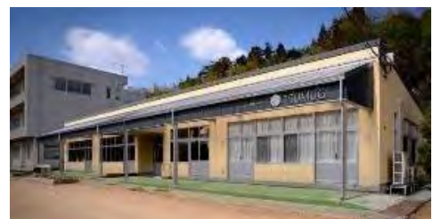
旧鳩原幼稚園を改修した校舎
