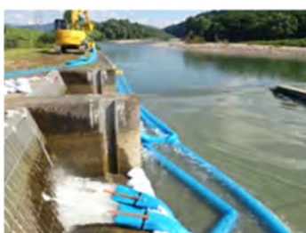
ポンプによる暫定取水を行う皆瀬頭首工(秋田県横手市)
