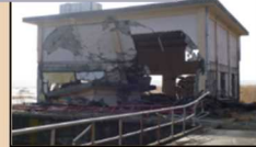
被災した排水機場
