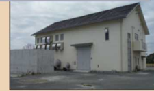
復旧が完了した排水機場
