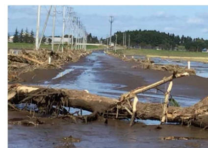
農道に土砂や流木が堆積
