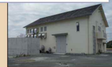
復旧が完了した排水機場
