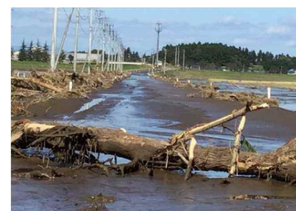
農道に土砂や流木が堆積
