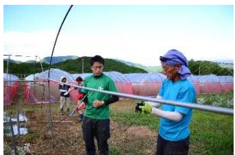
パイプハウスの設置作業
