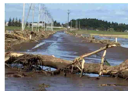
農道に土砂や流木が堆積
