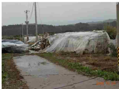
倒壊した農業用ハウス
