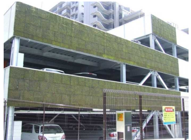
駐車場の壁面緑化
