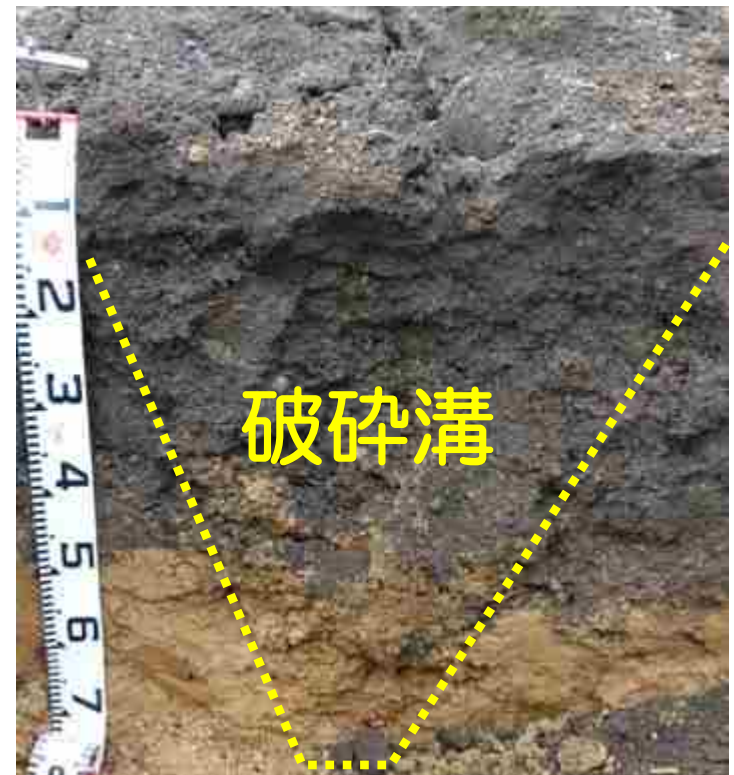
カットブレーカーの施工後の断面
