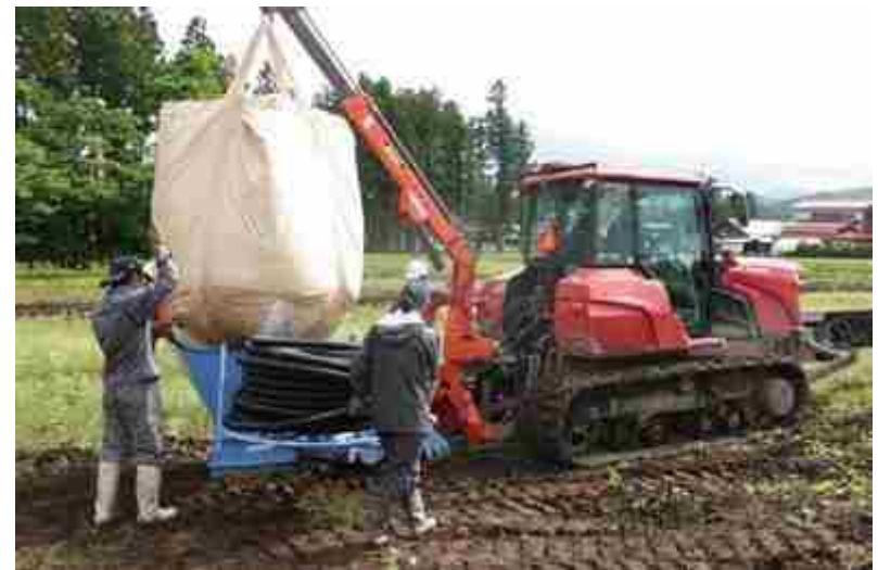
モミガラ疎水材による施工時の状況
