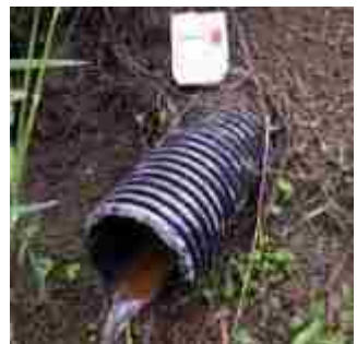
落水口の処理
