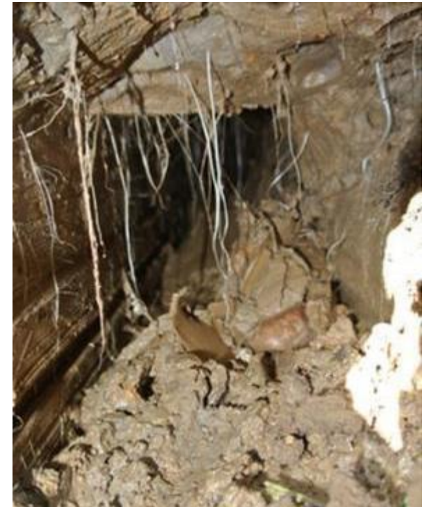
施工後 2 年空洞内
