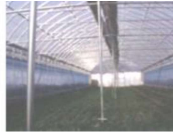
中柱（仮支柱）設置の写真
