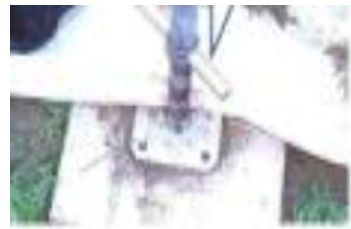
中柱（仮支柱）の根元の写真
