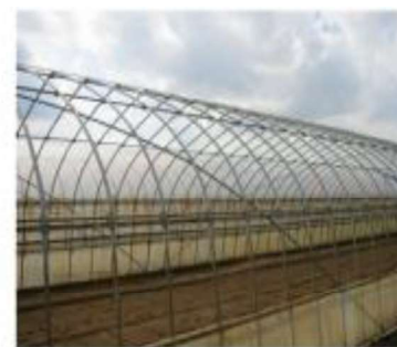
筋交いを入れた写真
