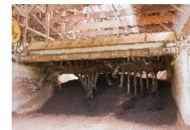
ロータリープラント
