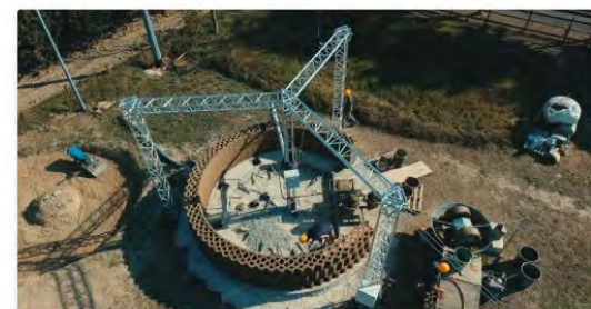
「ライス・ハウス」を造形中のクレーンタイプの新型3Dプリンター
