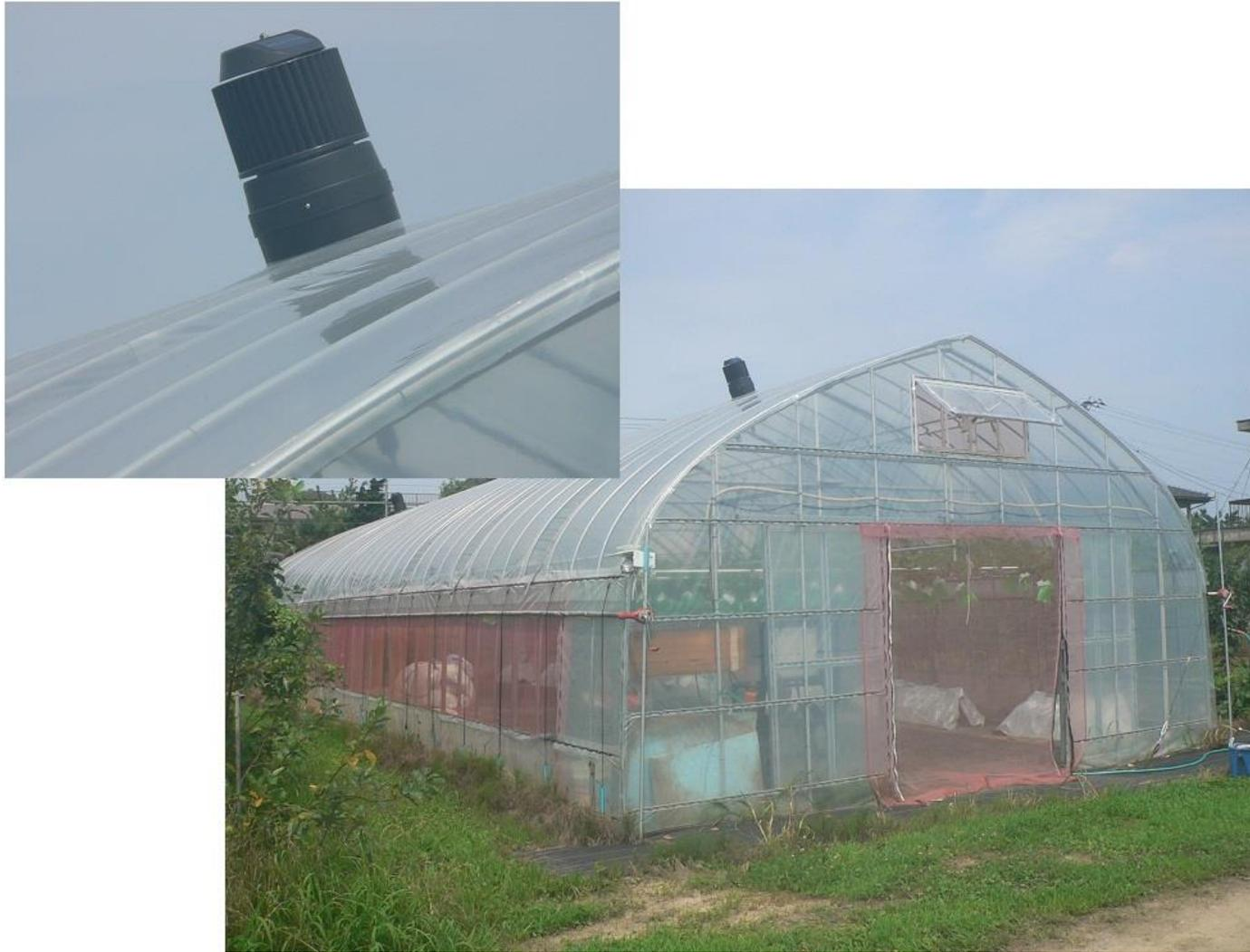
天頂部の小型換気扇による熱気の排気
