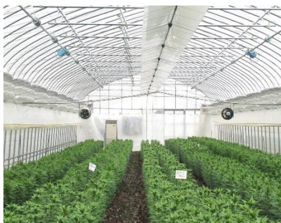
内張の多層化や循環扇の設置により最新ハウスではヒートポンプのみで加温
