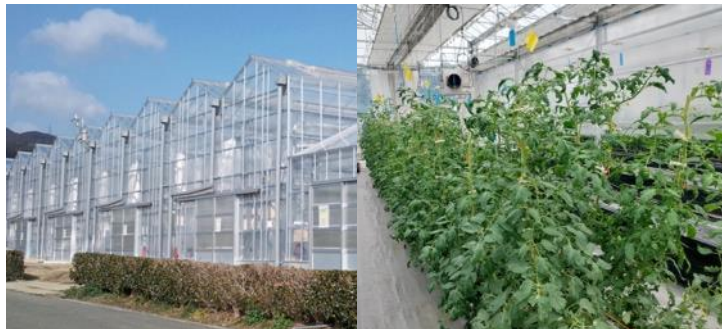
栽培検証施設
