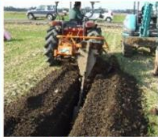
暗渠排水の整備
