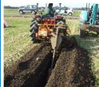
暗渠排水の整備
